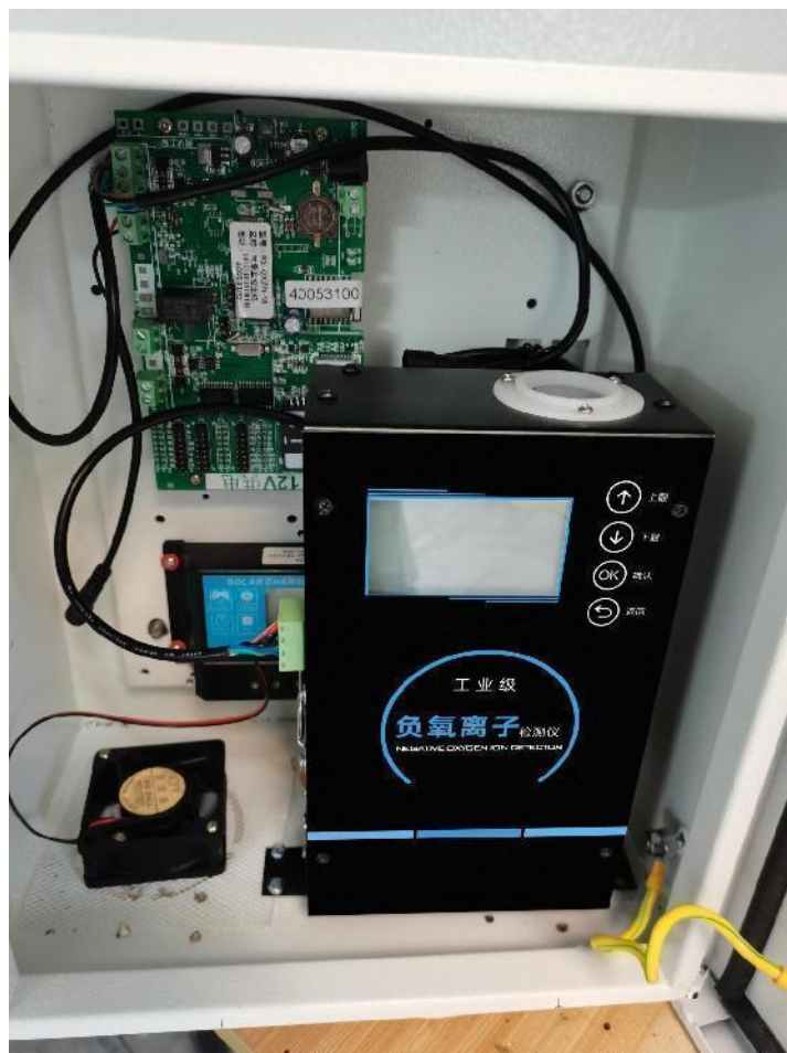
安装完成正面图
